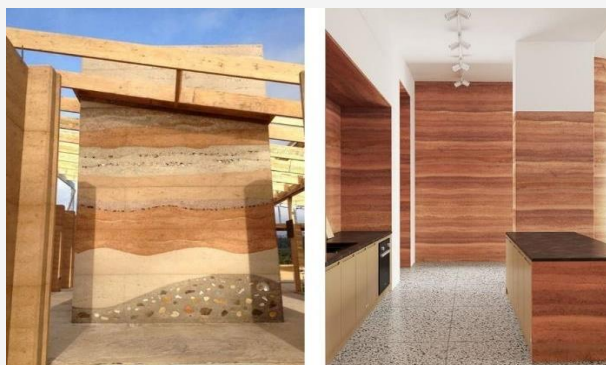
ภาพที่ 11 ผนัง Rammed Earth
