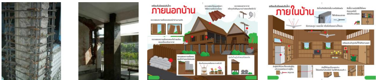
ภาพที่ 4 ความเสียหายเหตุการณ์แผ่นดินไหว
