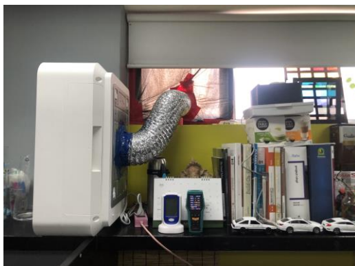
ภาพที่ 5 ตำแหน่งการติดตั้งเครื่องเติมอากาศและแผ่นกรองอากาศ MERV12 และ HEPA13
