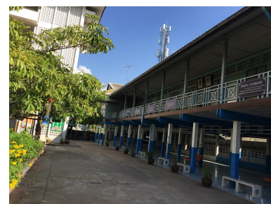
ภาพที่ 10 การใช้ประโยชน์จากอาคารเรียนรูปแบบใต้ถุนโล่ง
